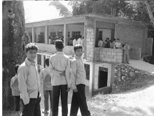
Baulicher Zustand der Hauptschule
